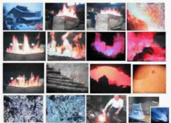
たたら製鉄など塊錬鉄法では強靱な鋼を直接作れるが 温度や送風管理などの操業技術が難しく容易に大量生産がしにくく、大量生産の容易な間接製鉄法に変わって行く。日本でも古代からずっと続いてきた「たたら製鉄」も 江戸末期近代洋式の間接製鉄法が入ってくると次第に間接法に置き換わった。
